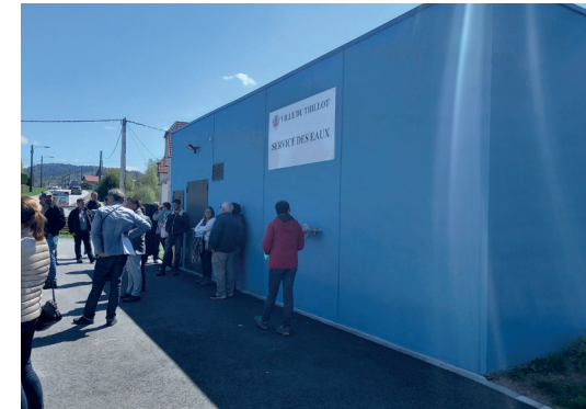
La ressource en eau potable : amélioration des rendements du réseau et pérennisation de la ressource - Nouvelle usine de traitement - Le Thillot
