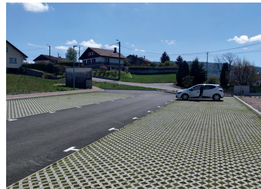
Désimperméabiliser la ville : parking perméable par des pavés engazonnés (Evergreen) - étang de Chaume à Le Thillot
