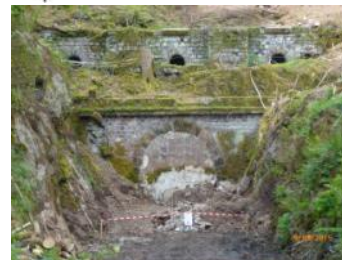
Tunnel de l'ancien Tacot, sous le Col des Croix au Thillot, et à proximité du secteur des mines.
