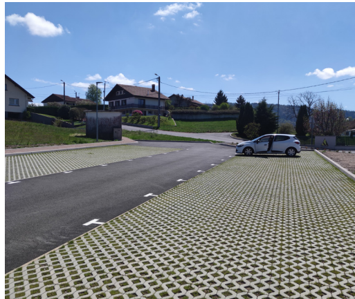
Désimpermeabiliser la ville : parking perméable par des dalles engazonnées (Evergreen) - Etang de Chaume à Le Thillot
