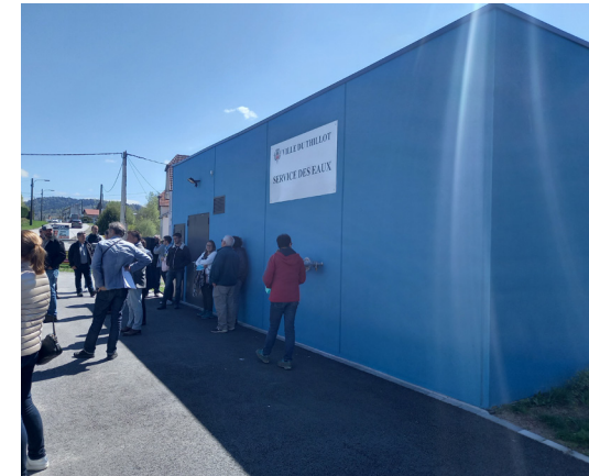
La ressource en eau potable : amélioration des rendements du réseau et pérennisation de la ressource - Nouvelle usine de traitement - Le Thillot
